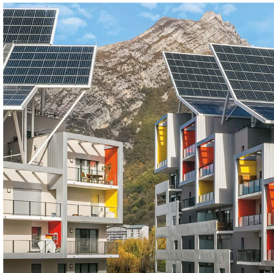
Bâtiment ABC de Grenoble (Autonomous Building for Citizens).
